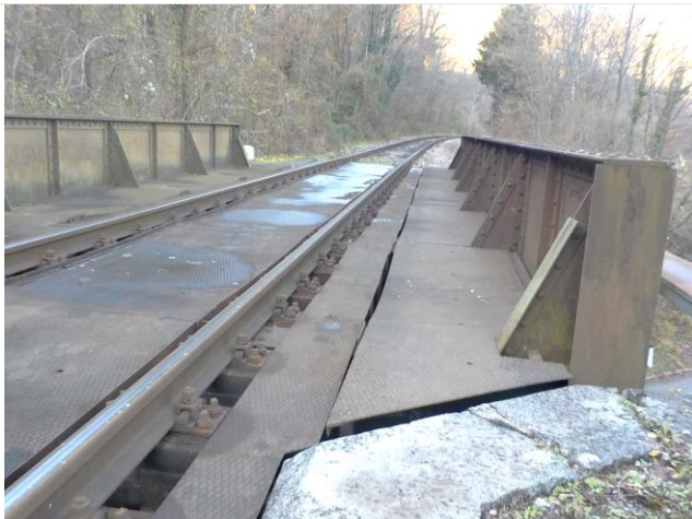
sl.21- pohodna pločevina hodnikov je upognjena/deformirana
