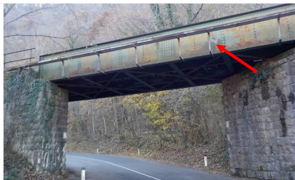
sl.2- glavni vzdolžni nosilec/levi: močna plastična deformacija stojine v sredini sestavljenega prereza. Morebitnih razpok osnovnega materiala v okolici vdolbine ni opaziti. Iz arhivskega gradiva: deformacija vidna že iz fotografije v letu 1963. Sanacija: NE
