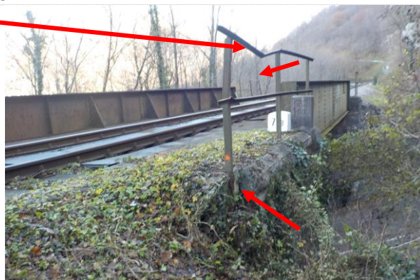
sl.6- odtrgan stebriček na desnem krilu opornika stran Jesenice, deformacija ograje – označeno s puščicama. Sanacija: DA
