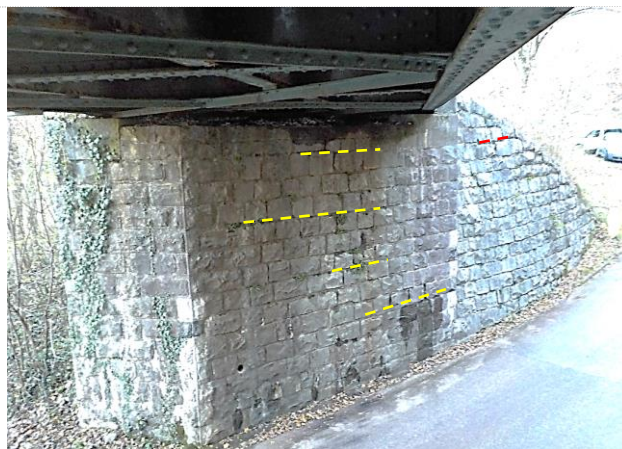
sl.24- opornik stran Sežana: lokacije preperelih fug med kamni (primer označenega se sanira)
