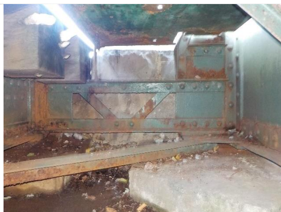
sl.20- pomični ležišči / sekundarni in glavni vzdolžnik stran Sežana
