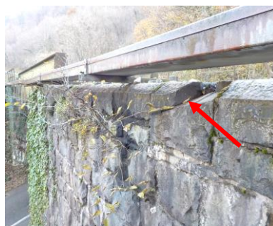
sl.30- razpoka in odkrušek v kamnitim bloku – ograjni venec
