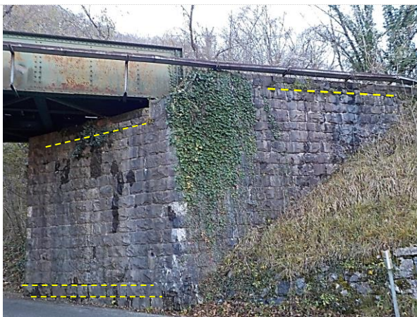
sl.23- opornik stran Jesenice: lokacije preperelih fug med kamni (primer označenega se sanira)
