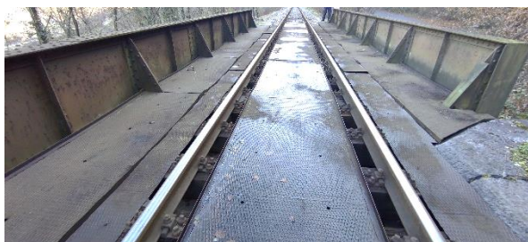
sl.1- pohodna pločevina na hodnikih ter v sredini med tiroma je upognjena / povešena (lokalno deformirana). V projektni nalogi je že podana zahteva o zamenjavi le te s cinkanimi rešetkami. Sanacija: DA
