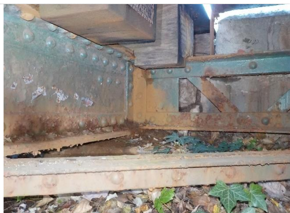
sl.18- pomično ležišče / sekundarni vzdolžnik stran Jesenice
