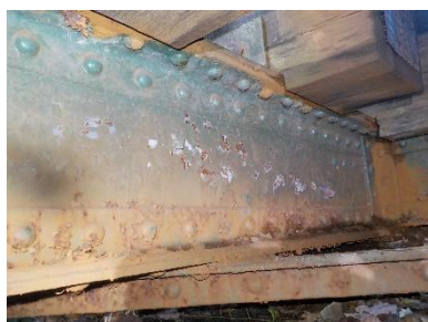
sl.10- korozija – elementi konstrukcije pod pragovi
