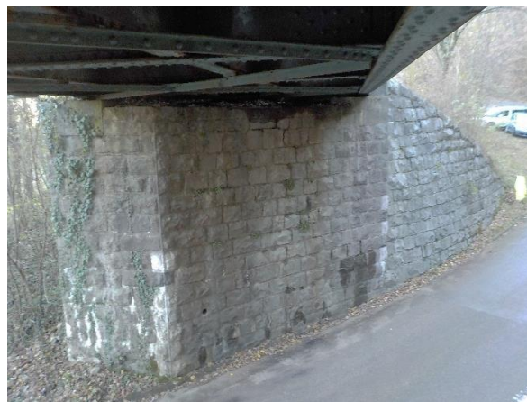
sl.14- opornik stran Sežana: lokalno bujno razraščanje vegetacije, lokalno izcejanje iz fug v spodnjem delu Sanacija/lokalna DA
