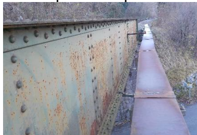
sl.7- korozija na glavnem nosilcu
