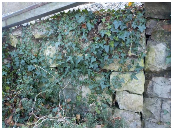
sl.15- levo krilo stran Sežana: razpadle fuge med kamni Sanacija: DA
