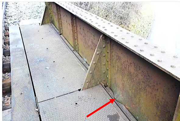
sl.4- deformacija stojine s fotografije 2 / notranja stran
