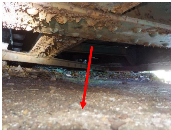
sl.28- opornik stran Jesenice: erodirana površina betona naklonske police (delno prekrito s listjem, zemljo, mahom)
