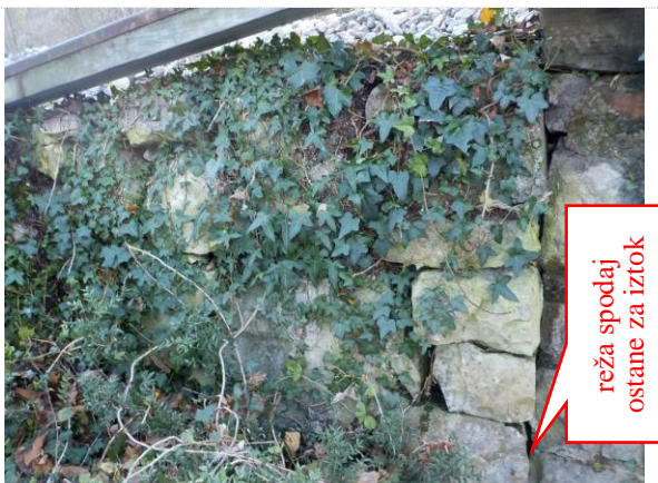
sl.25- opornik stran Sežana: levo krilo (pod kineto) - odpadle fuge med kamni / v celoti razen označenega
