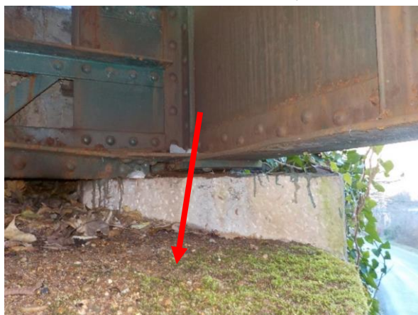
sl.27- opornik stran Sežana: erodirana površina betona naklonske police (delno prekrito s listjem, zemljo, mahom)
