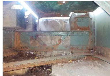
sl.9- korozija – elementi konstrukcije pod hodnikom
