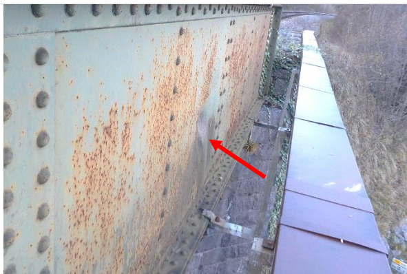
sl.3- deformacija stojine s fotografije 2 / zunanja stran
