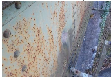
sl.8- korozija na glavnem nosilcu
