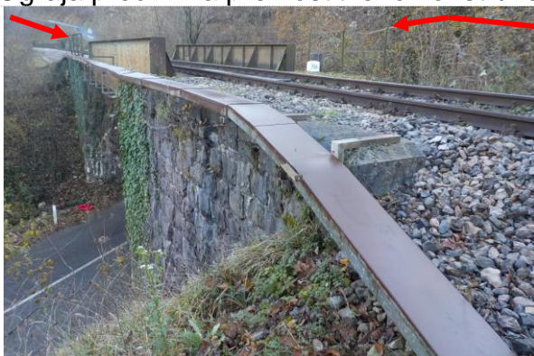
sl.5- manjkajoča ograja na levem krilu opornika stran Jesenice, deformacija ograje – označeno s puščicama. Sanacija: DA
