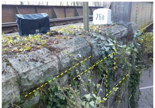
sl.26- opornik stran Jesenice: desno krilo - preperle fuge med kamni / lokalno tudi kamni venca krila (sanacija DA)
