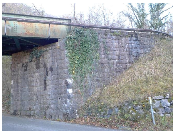
sl.13- opornik stran Jesenice: lokalno bujno razraščanje vegetacije, lokalno izcejanje iz fug Sanacija/lokalna DA
