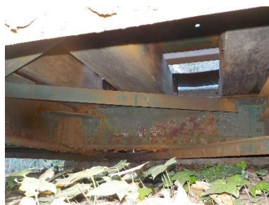
sl.11- korozija – elementi konstrukcije pod pragovi
