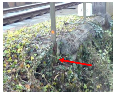
sl.31- razpoka in odkrušek v kamnitim bloku – ograjni venec
