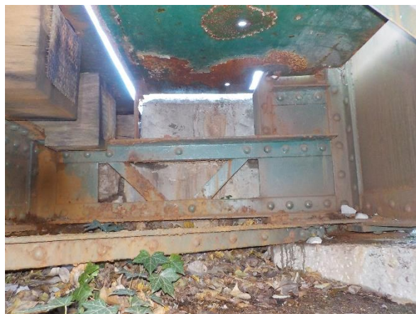
sl.16- naklonska polica med ležišči stran Sežana: pretežno pokrito s plastjo zemlje/listja/kamenja/vegatacija
